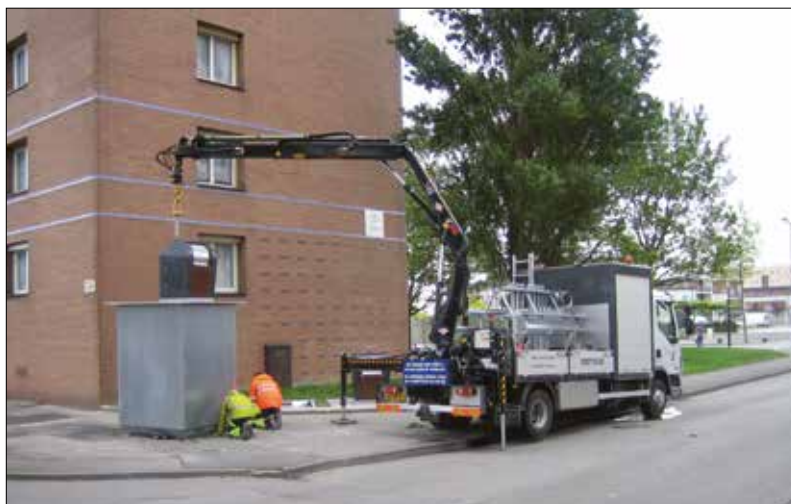
Travaux d'entretien annuel.
