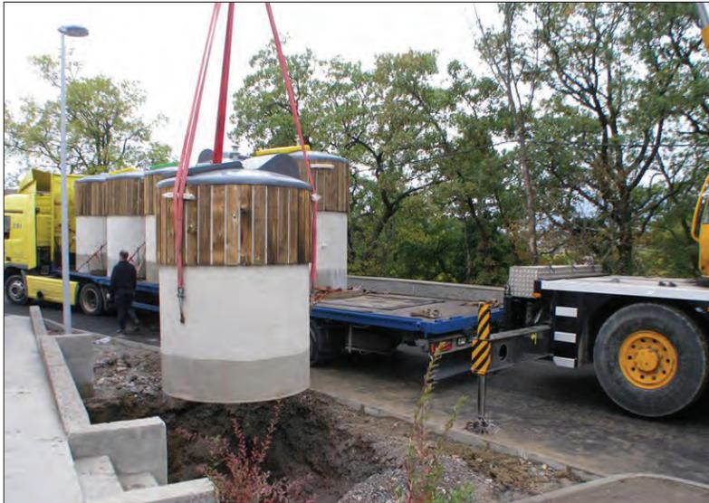
Einbau von Tierso-Systemen in Gap (Frankreich); nach dem Verfüllen der Baugrube ist das System einsatzbereit.
