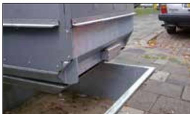
**La cuve enterrée est ouverte dans le fond afin que l'eau n'y stagne pas.**
