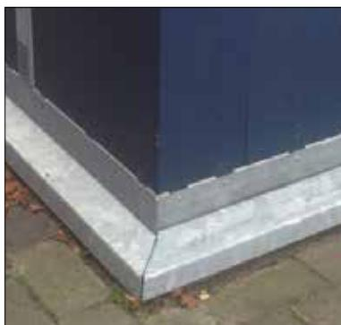
**Un profil comble la fente entre la cuve enterrée et le conteneur, afin que du sable ou des feuilles ne puissent pas y pénétrer.**
