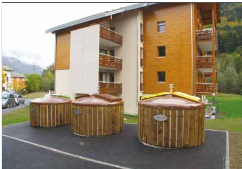
Tièrso dans un complexe de soins à Pau, France.
