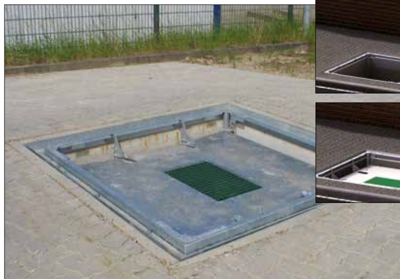
Sol de sécurité, alternative à la barrière de sécurité.
