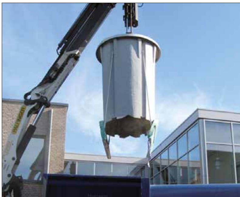
Vidage, ici par un camion avec grue kinshofer.
