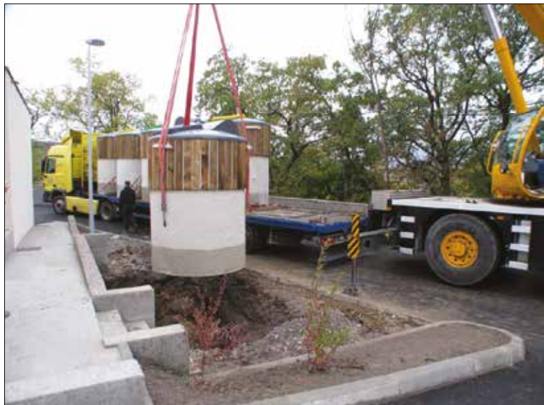
Installation de conteneurs Tiërso à Gap (France). Après le remblayage de l'excavation, le système est prêt à l'emploi.
