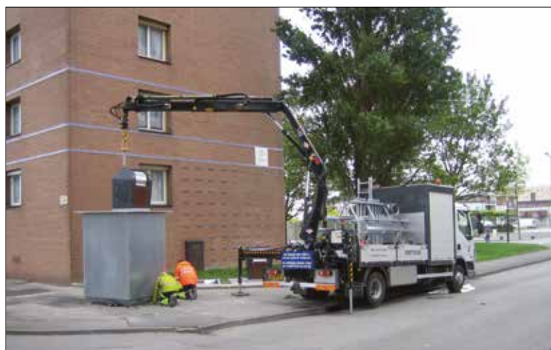
Travaux d'entretien annuel.
