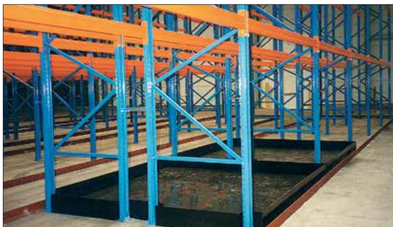
Bacs de rétention, convenant aux racks dans cet entrepôt de palettes.
