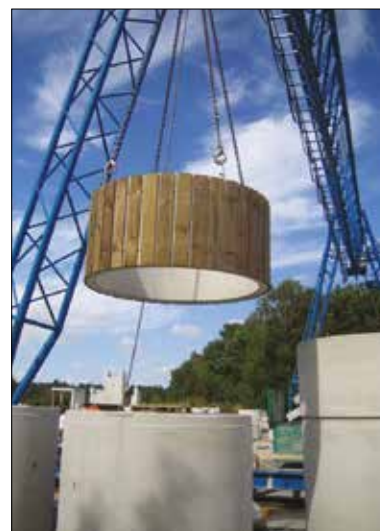
Dans l'usine de béton, les deux parties du silo sont déjà jointes.
